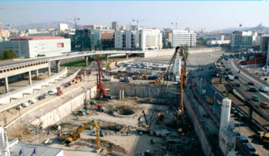
LES QUAIS D'ARENÇ
