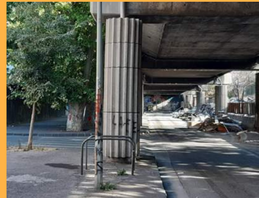
Avant les travaux - Crédit : DR Euroméditerranée
